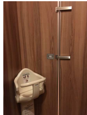
全施設共通 鍵を追加で設置
